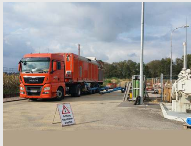
Bild 2: Mobiler Verdichter während eines Umpumpeinsatzes
