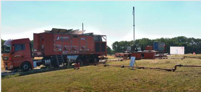
Bild 5: Kombiniertes Einsatz von Verdichter und Fackel zur Entleerung einer Erdgastransportleitung
